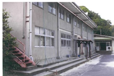
修繕工事が予定される女子運動部室棟
